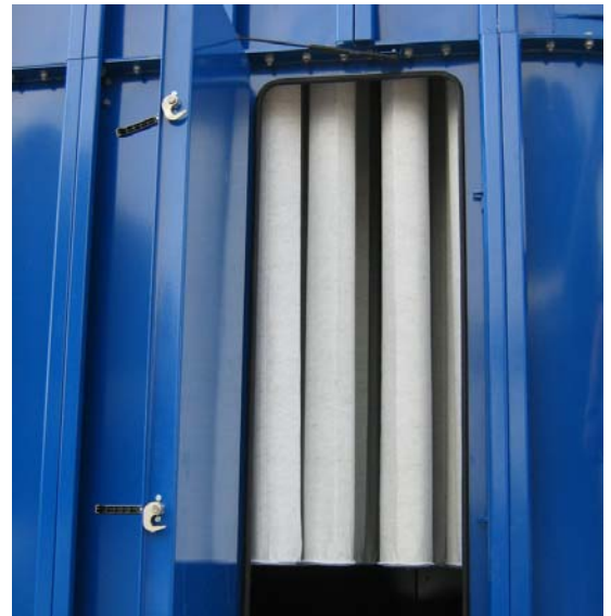
Nye filterposer der er leveret fra egen produktion er isat og klar til drift.
